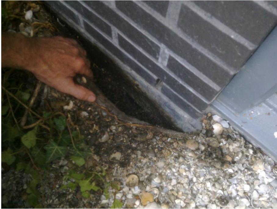
Foto 4: Beschermende laag is tegen loodslab opgezet .Water kan capillair omhoog komen.
