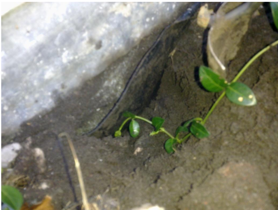
Foto 5: Beschermende laag tegen loodslab.
