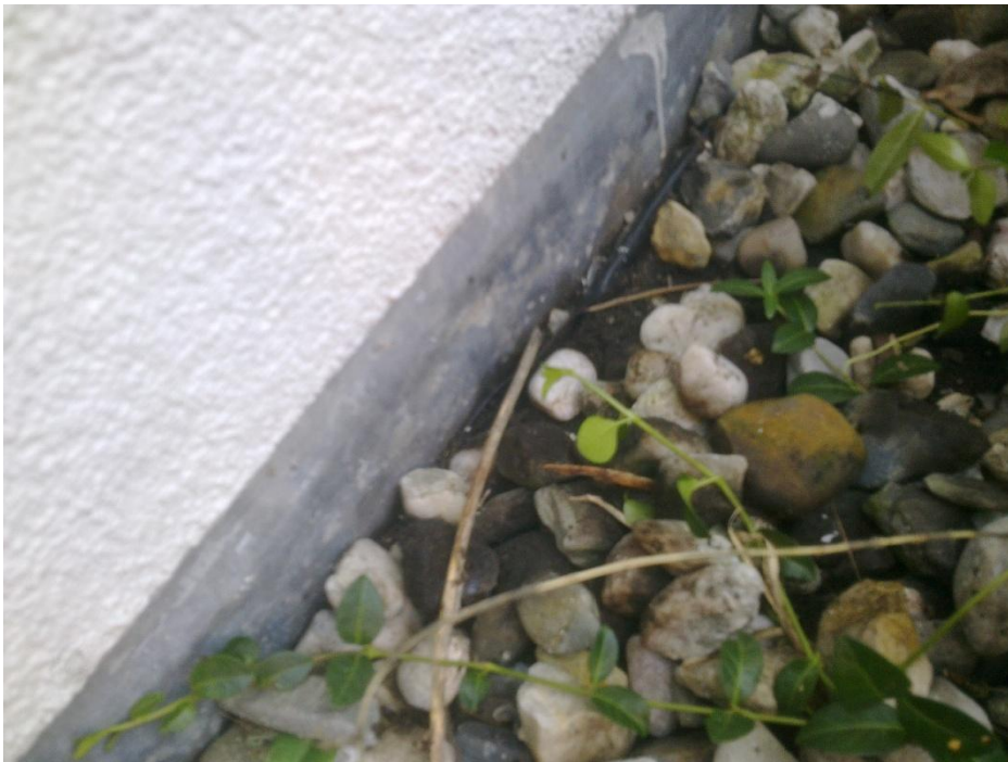
Foto 1: Grond en grind tegen beschermende laag. Loodslab niet vrij.
