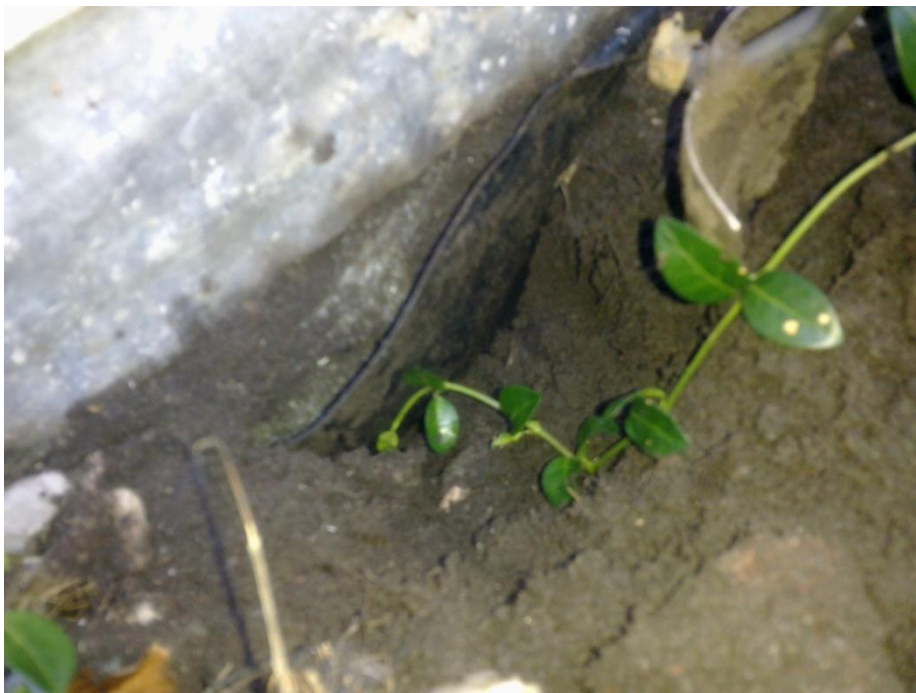
Foto 5: Beschermende laag tegen loodslab.
